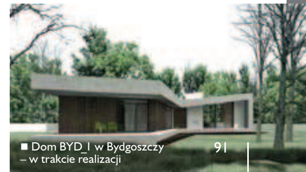
■ Dom LUSO_1 w Lusówku koło Poznania – w trakcie realizacji
